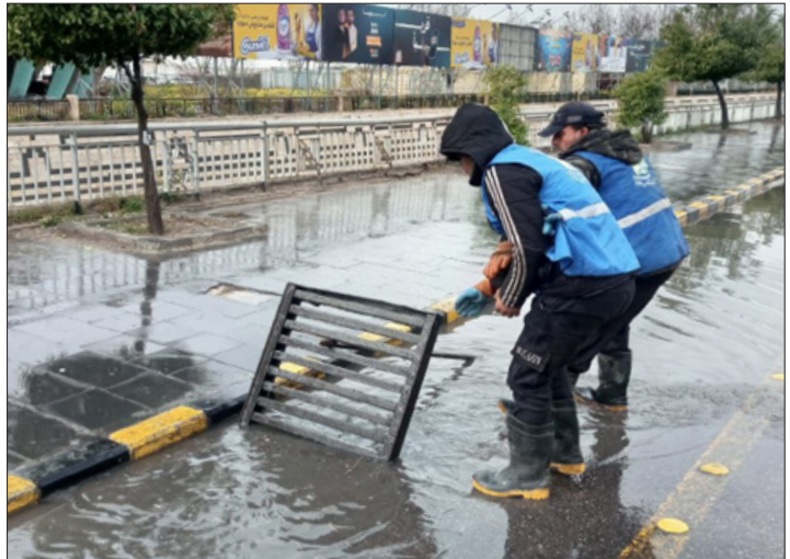
أعمال صيانة الصيانة الخدمية في مدينة دمشق لتصرف مياه الأمطار ومنع حدوث فيضانات - 19 أدر 2026 (محافظة دمشق)
