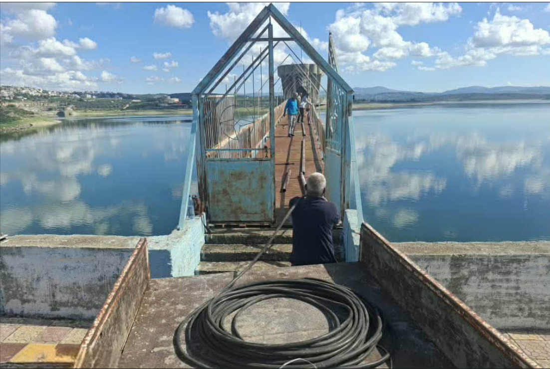
عمال يمدون كابول الخفية الكبرألة لوجبات التحكم بوابات سد الأرش في طرطوس - 26 تشرين الأول 2026 (مديرية الموارد المائية في طرطوس)
