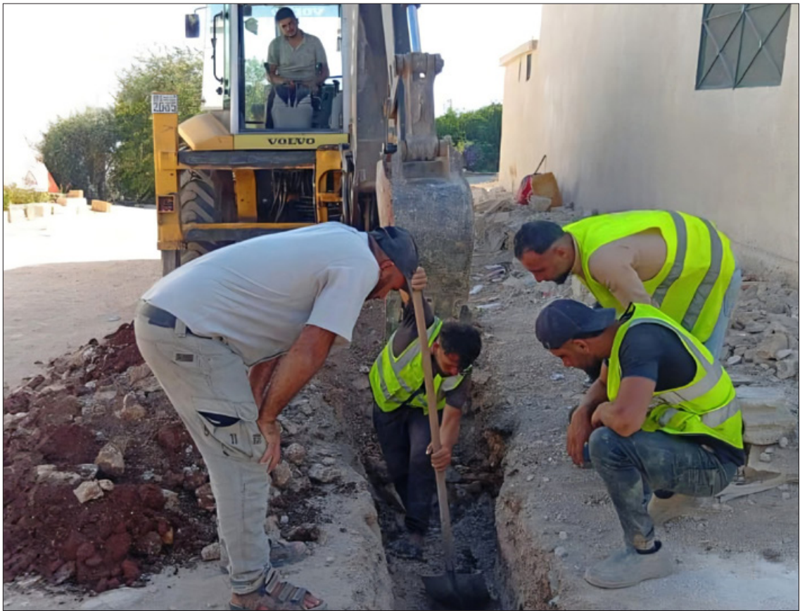
الشركة العامة لمياه الشرب والصرف الصحي في محافظة حماة تطلق مشروعاً مائياً في بلدة كرناز بريف حماة - 21 أيلول 2026 (مديرية مياه حماة)
