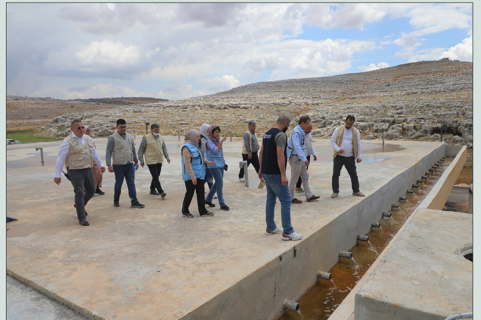
مشروع معالجة مياه الصرف الصحي الممول من "يونيسف" و"SCHF"، وتمتدّه "IHR" وشركة بناء للتنمية في إدلب - 14 من أيار 2024 (CHA/Mohanad Zayat)
