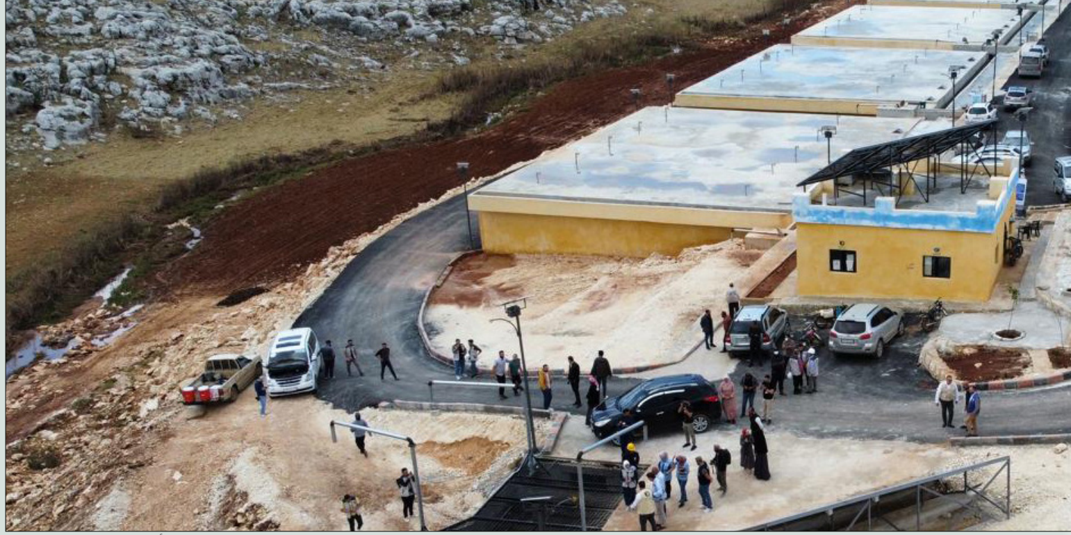
مشروع معالجة مياه الصرف الصحي الممول من "يونيسف" و"SCHF"، وتنفذه "IHR" وشركة بناء للتصميم في إدلب - 14 من أيار 2024 (CHA/Mohamad Zayat)
