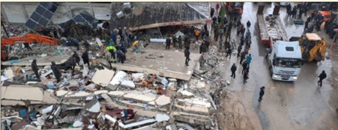
بناء نقابة الأطباء في مدينة جبلة الذي انهيار نتيجة الزلزال الذي أودى بحياة ثلاثة أطباء من ضمن ضحايا البناء - 6 من شباط 2023 (صحب بلدي / أيمن علي)
