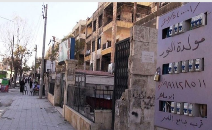
قواطع كهربائية لمولدة كهرباء في حلب - 2018 (أرشيف)
