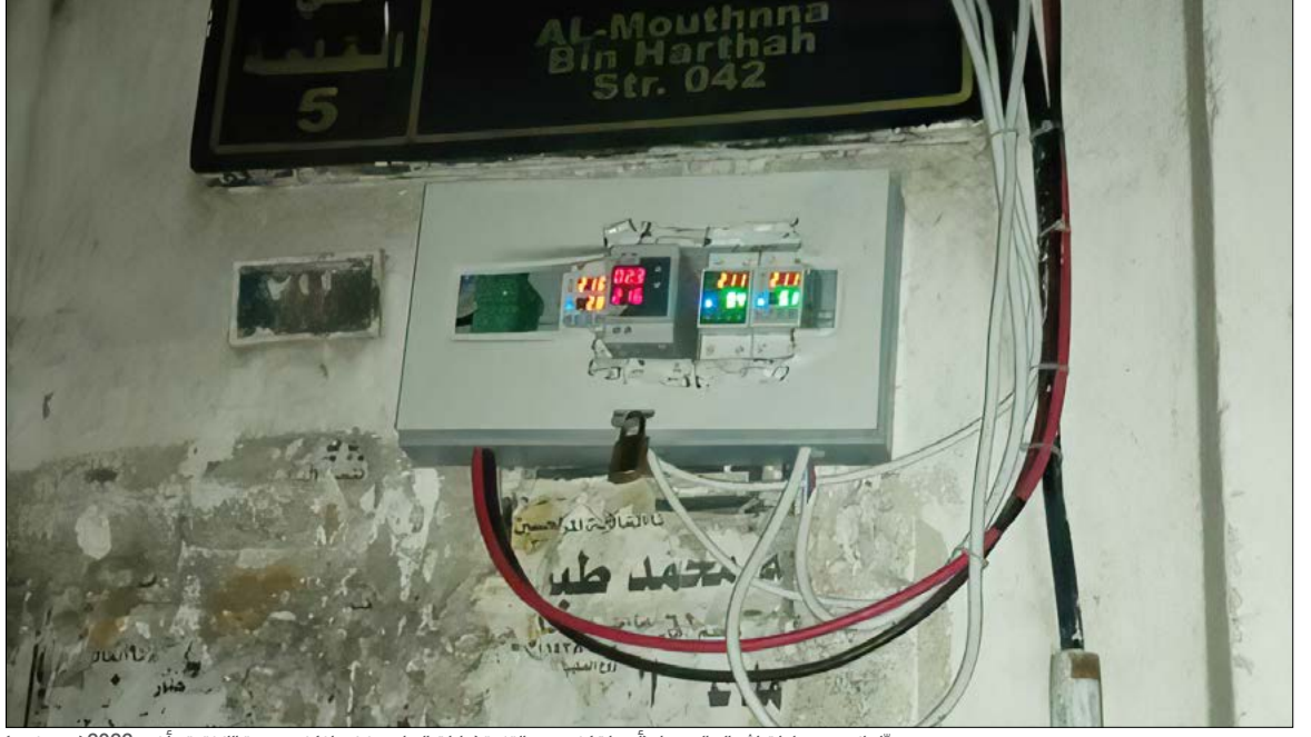
عداد لإحدى مولدات اشتراك الكهرباء (أمبيرات) في حي القلعة (بنايات السابع من نيسان) في مدينة اللاذقية - أيلول 2022 (عنب بلدي)
