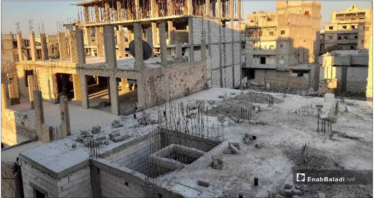
منازل طابقية غير مكتملة البناء ضمن مدينة الرقة شمالي سوريا - 6 من تموز 2021 (عنب بلدي\ حسام العمر)
