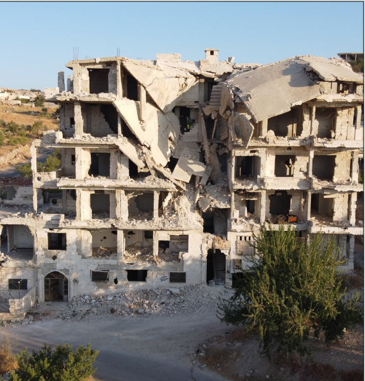
بناء مدمر نتيجة القصف في مدينة أريحا بريف إدلب الجنوبي - 23 أيلول 2020 (عنب بلدي / يوسف غريبي)
