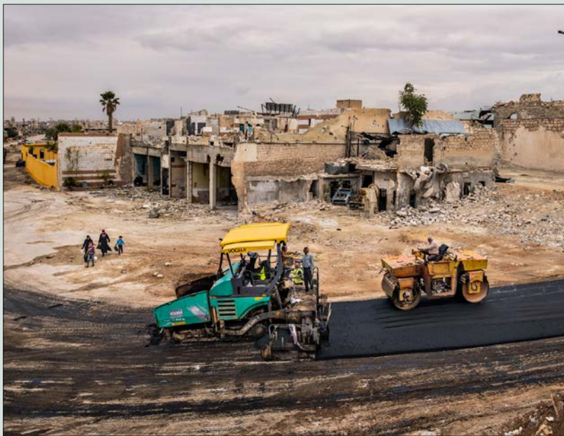
عمال بناء يقومون بعمليات الترميم بالقرب من مطار حلب شرق حلب - شباط 2019 (ناشيونال جيوغرافيك)
