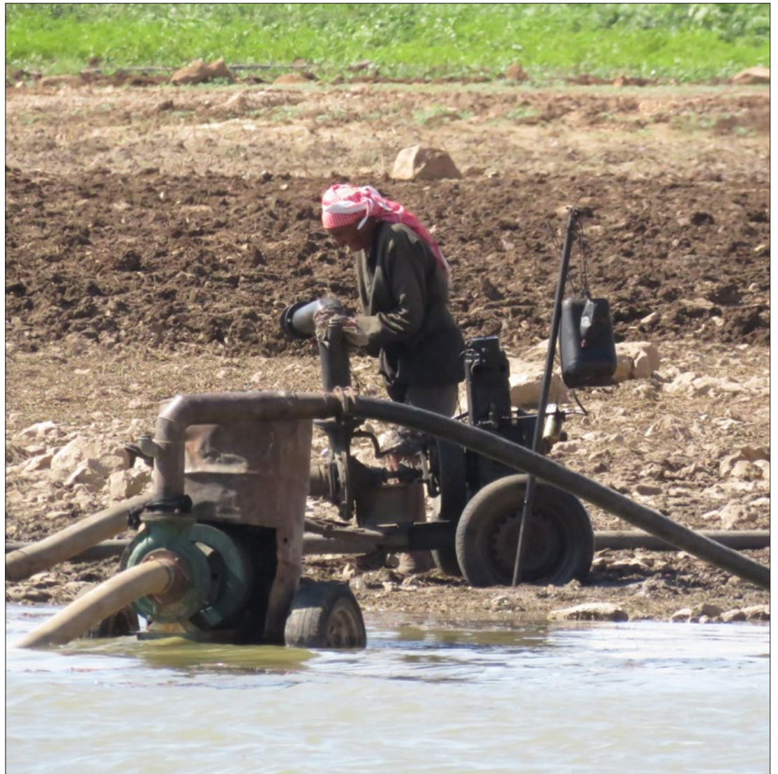
فلاح يتفقد مضخة مياه على سد قسطنون في ريف حماة - تموز 2017 (عنب بلدي)
